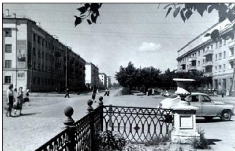
Комплекс жилых домов Барнаульского меланжевого комбината на проспекте Калинина. Справа виден 32-х квартирный дом. Фото 1954 г. ГААК. Фотоальбом № 36
