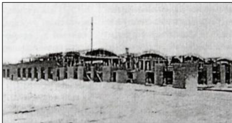
Строительство Барнаульского завода искусственного и синтетического волокна № 521. На верхнем снимке - кордовый корпус № 1, южный фасад. На нижнем снимке - опытная установка К-21, внешний вид. Фото 1951 г. из фондов ГААК.
