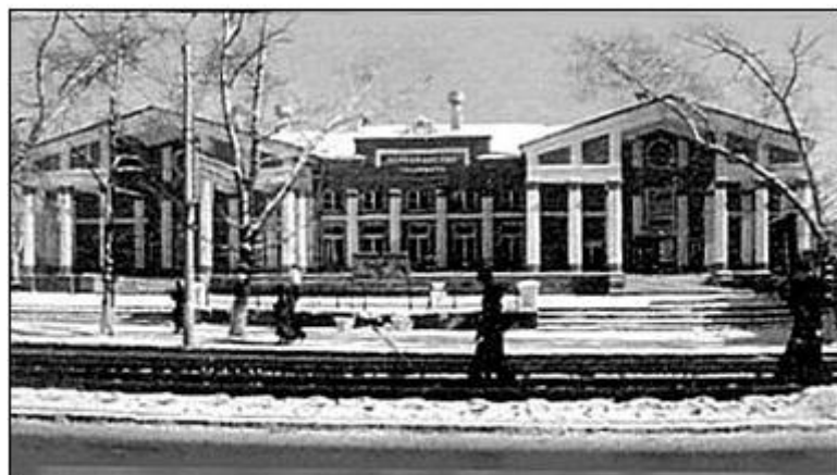
Кинотеатр «Первомайский» по пр. Красноармейский, 58. Здание было построено в 1956 году. В настоящее время строение полно- стью снесено и на его месте планируется построить высотное зда- ние. Фото середины 1980-х гг.
