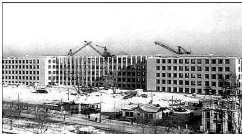
Строительство главного корпуса Алтайского политехнического института. На переднем плане видны частные дома и здание аптеки № 4 на Ленинском проспекте (в правой стороне снимка). Фото 1962 г. из фондов АГКМ.
