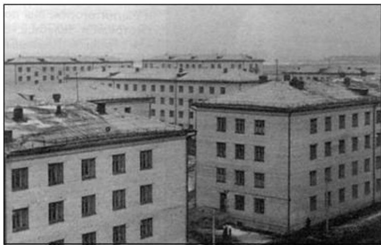
Поток через два года после начала строительства. 1959 г.
