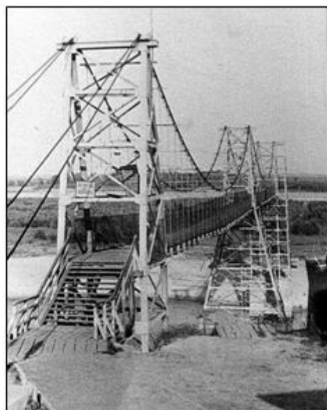
На верхнем снимке левая береговая опорная мачта подвесного моста, на нижнем - правая береговая мачта. Фото начала 1960-х гг
