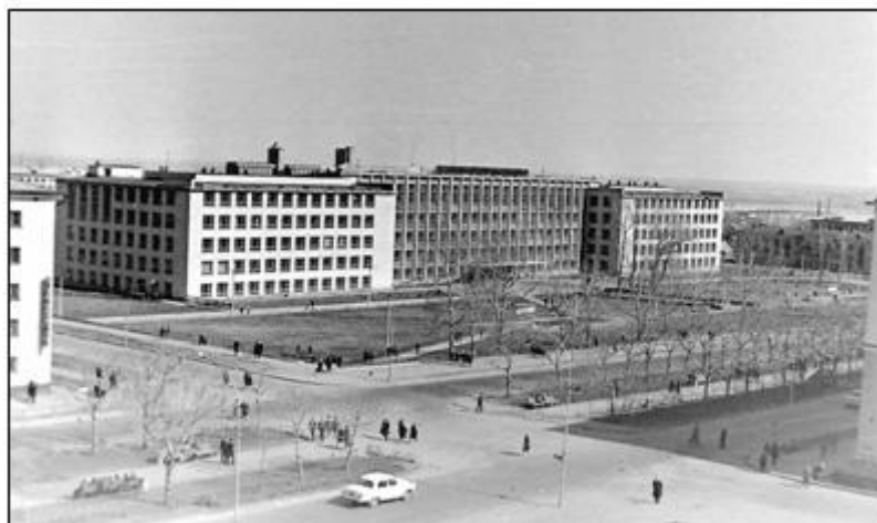
Главный корпус Алтайского политехнического института (ныне Алтайского государственного технического университета). Здание построено трестом «Стройгаз» в 1959-1963 гг. Архитектор А.Тишкина. Фото 1960-х гг.
