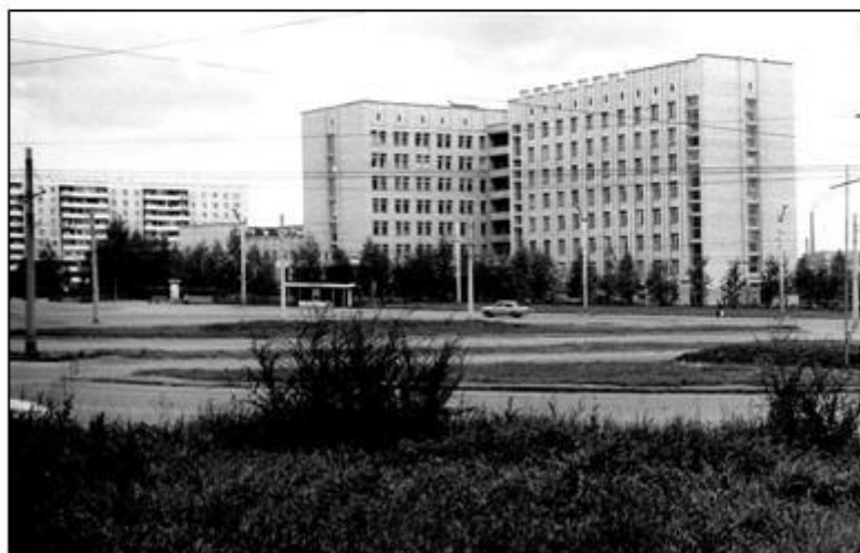
Алтайский краевой кардиологический диспансер. Семизэтажное здание построено в 1988 г. (ул. Малахова, 46).
