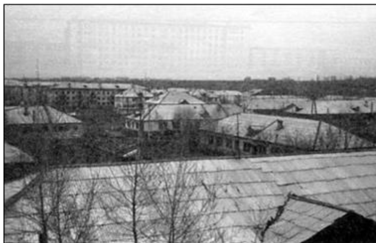
Деревянные бараки на Потоке по ул. Глушкова. Фото Люкшенко, конец 1950-х гг.
