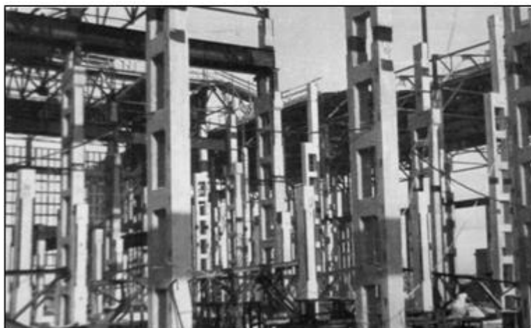
Строительство цеха алюминиевого литья в Алтайском моторном заводе. В декабре 1972 г. цех выдал первую плавку металла.
