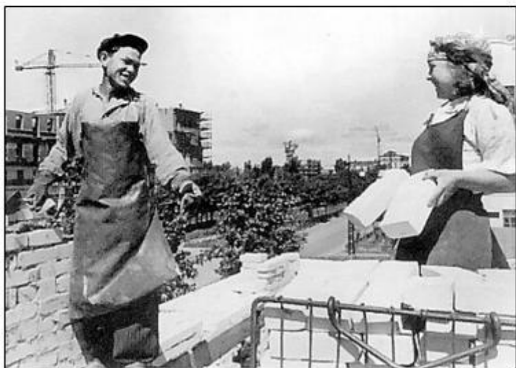
На строительстве главного корпуса Алтайского сельхозинститута. Фото 1954 г. из фондов АГКМ.
