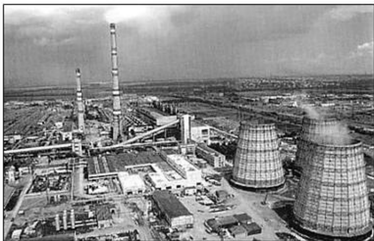
Власихинский промузел. На снимке панорама Барнаульской ТЭЦ-3.
