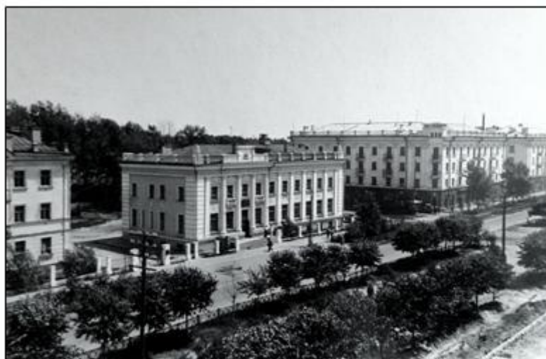
Вид на пр. Ленина около перекрестка с ул. Молодежной. На снимке видны здания Краевой конторы Промбанка и жилые дома завода транспортного машиностроения (пр. Ленина № 62 и 60). Фото 1953 г. ГААК. Фотоальбом № 36..
