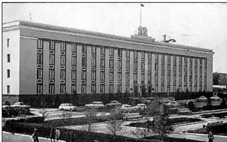
Дом Советов. Здание построено в начале 1960-х годов по проекту архитекторов М.А.Файнберга, Л.Ю.Гальпера, В.В.Горбачева. (пр. Ленина, 59). Фото 1960-х гг.
