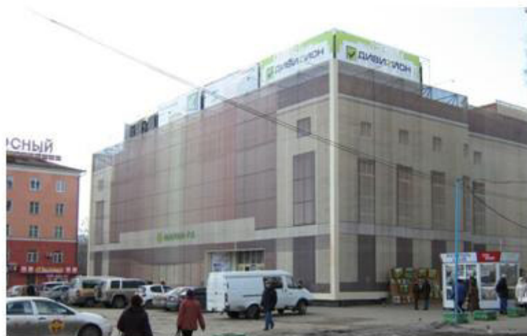
Здание Центрального универмага, построенное в 1964 году.. (пр. Ленина, 55). Фото автора, 2008 г.
