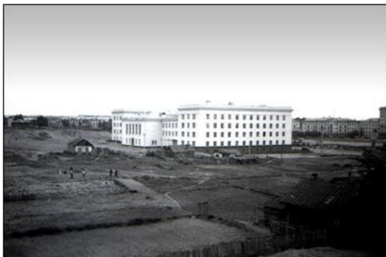
Здание Крайисполкома. Вид с юго-западной стороны. Окружающая территория еще не застроена, видны частные дома и огороды. Фото начала 1960-х гг. А.С. Антошкина.
