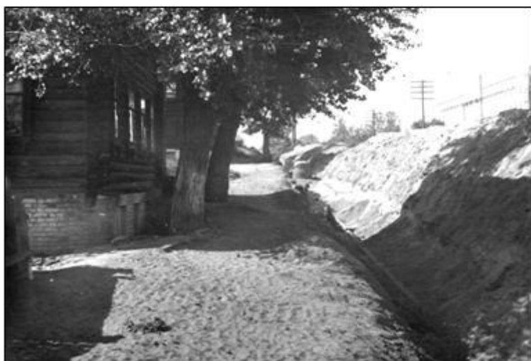
Траншеи для укладки водопровода по ул. Партизанской. Фото Л.И.Борисенко из фондов АГКМ. 1953 г.
