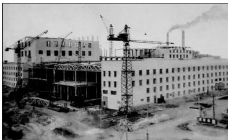
Строительство производства большого капрона на Барнаульском комбинате химволокна. Стройку ведет трест Стройгаз. Фото 1967 г.
