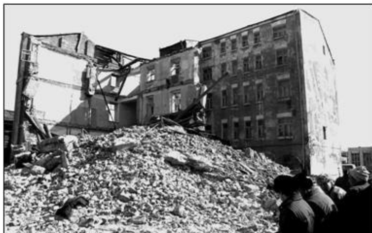
Красноармейский пр. и угол с ул.Гоголя. Реставрация дома, в свое время прозванного «небоскребом». Фото Б.П.Брызгина из фондов АГКМ. 1990 г.
