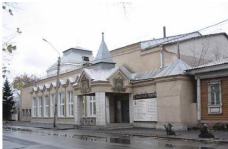
Здание театра кукол «Сказка». На этом месте с 1927 г. работал кинотеатр «Горн», в 1944 г. был открыт кинотеатр «Победа». В 1965 г. после перестройки здания вновь, здесь начал работать Дом культуры УВД, с 1970 г. в здании размещается театр кукол. (ул. Пушкина, 41). Фото автора, 2007 г.
