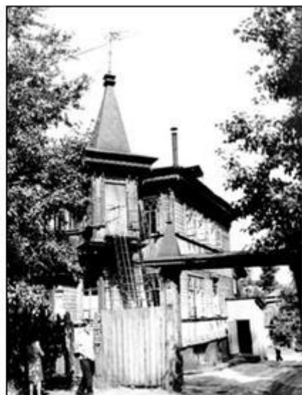
Бывший дом архитектора И.Ф.Носовича по ул. Чернышевского, постройки 1908 г. Архитектурный памятник деревянного зодчества. В связи с новой застройкой улицы дом подлежал сносу. В 1988 г. перенесен на ул. Анатолия, 106. Фото 1970-х гг.
