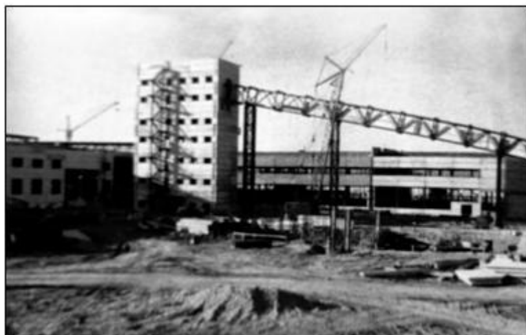
Строительство завода железобетонных изделий 100. Строительство начато в 1987 г. Первая очередь завода введена в действие в 1991 г. Строительство завода вел трест «Стройгаз».
