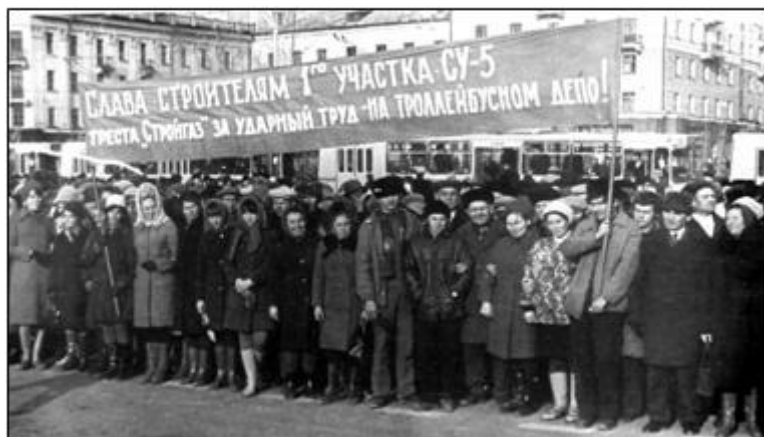
Митинг, посвященный окончанию строительства троллейбусного депо. Фото 1973 г.
