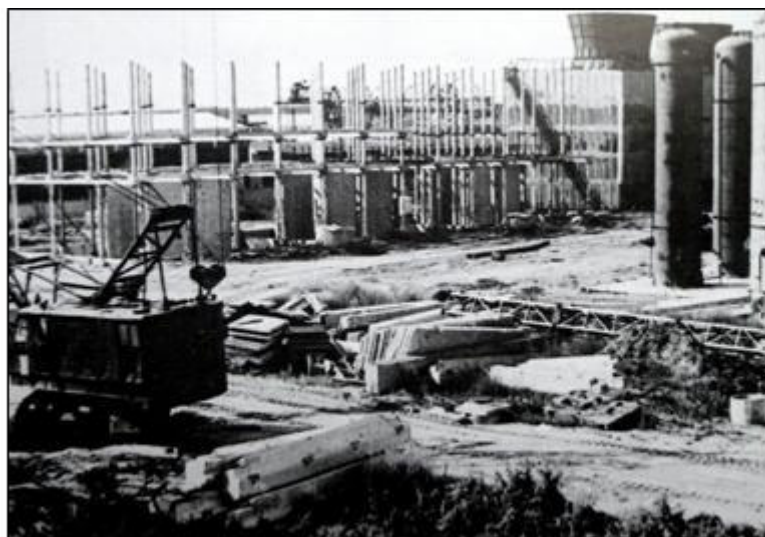
Строительство цеха регенерации капролактама на ЗСВ. Фото 1980-х гг.
