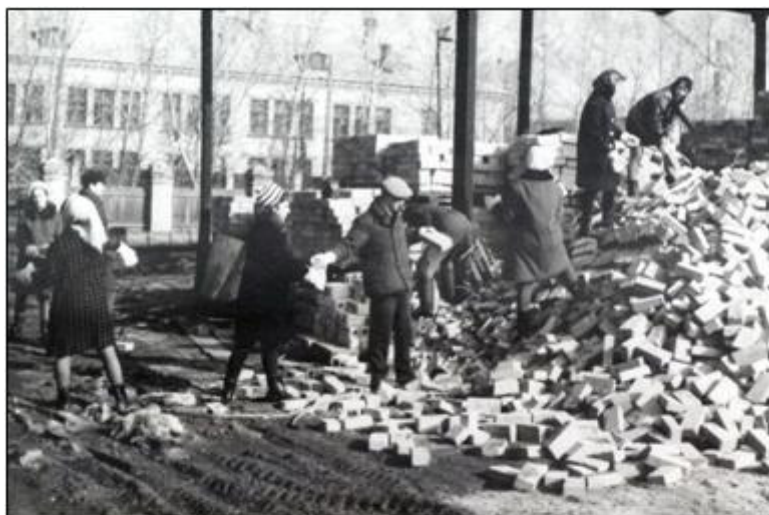
Субботник на строительстве Дворца культуры котельщиков. Уборка кирпича. Фото В.Барило. 1971 г. ГААК. Фотопозитив № 3991.
