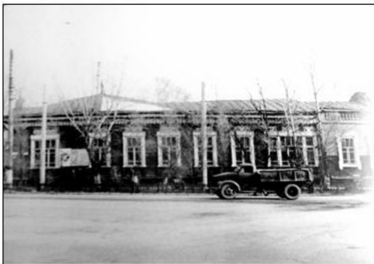
Здание бывшей конторы купца А.Г.Морозова, постройки конца XIX века по пр. Социалистический 16. Фото 1980-х гг. из фондов музея «Город». В настоящее время здесь размещаются различные магазин- чики, фасад здания изрезан дверными проемами
