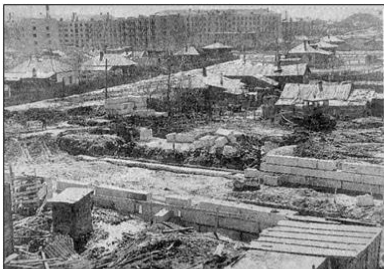
Строительство жилых домов по улицам Брестской и Деповской. Фото 1963 г.
