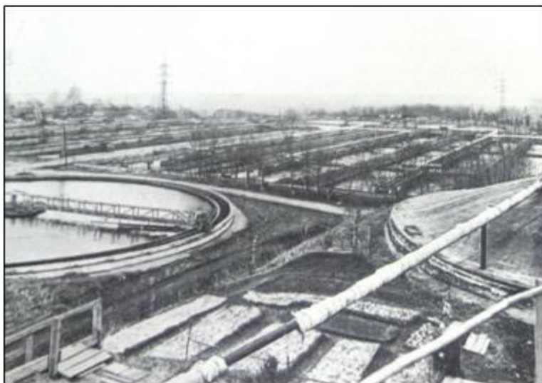
Канализационные очистные сооружения на Восточном поселке. Фото 1960-х гг.
