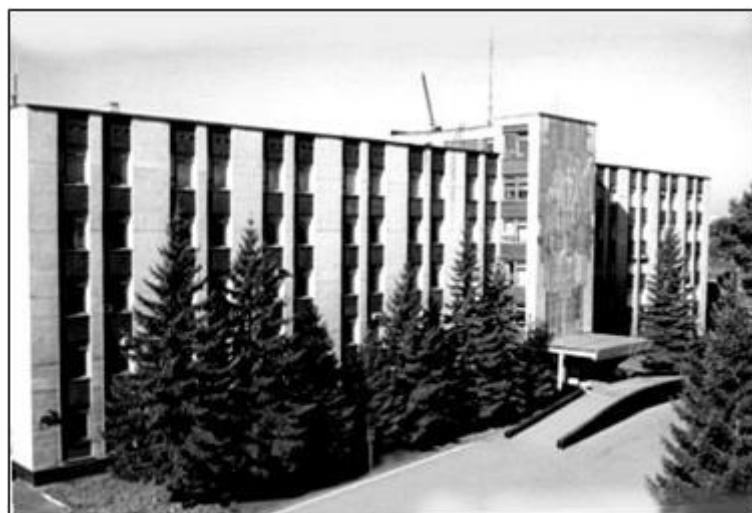
Новое здание Алтайского отделения железной дороги (пл. Победы, 8). Фото 1970 г.
