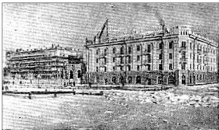
Строительство жилых домов в районе площади Советов. (пр. Ленина, 58 и 60). Фото конца 1950-х гг.
