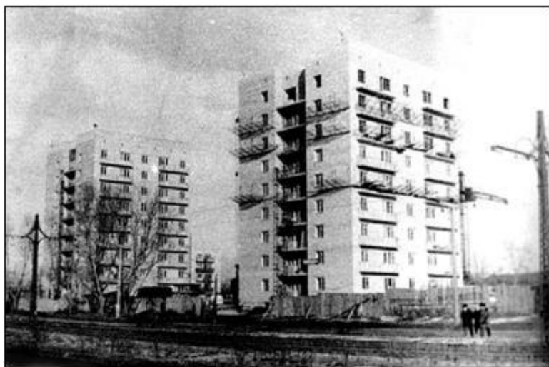
Проспект им. Ленина в районе Нового рынка. На снимке строительство первых девятиэтажных жилых домов в Барнауле. (пр. Ленина, 96-102). Фото 1960х годов..
