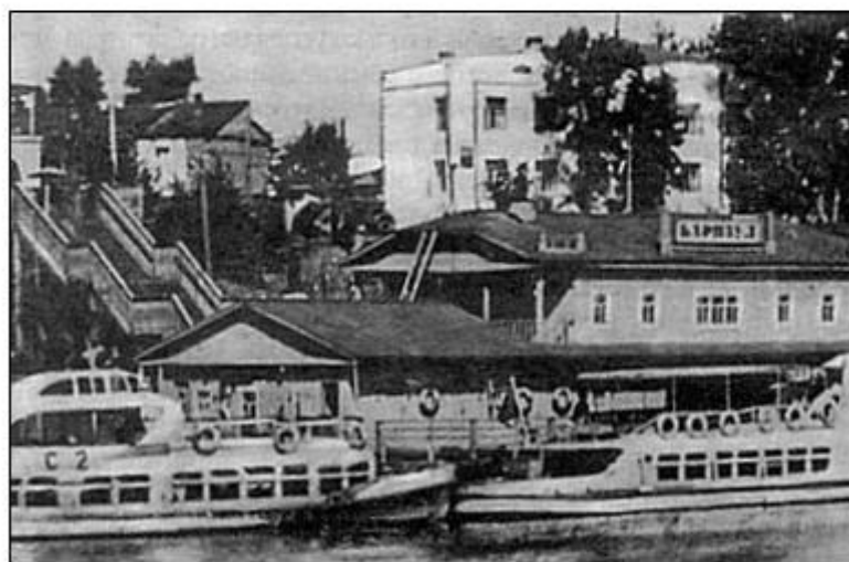
У начала улиц Ползунова и Пушкина на берегу Оби у причала стоял деревянный дебаркадер, это и была речная пристань, которую называли речным вокзалом. Справа за вокзалом видна контора пристани, слева, за лестницей, ресторан «Волна». Фото 1960-х гг.
