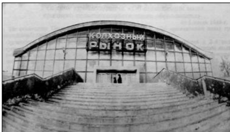
Завершение строительства павильона колхозного рынка на Старом базаре 28 декабря 1986 г. Фото А.Волобуева из фондов ГААК. Фотопозитив № 8144.
