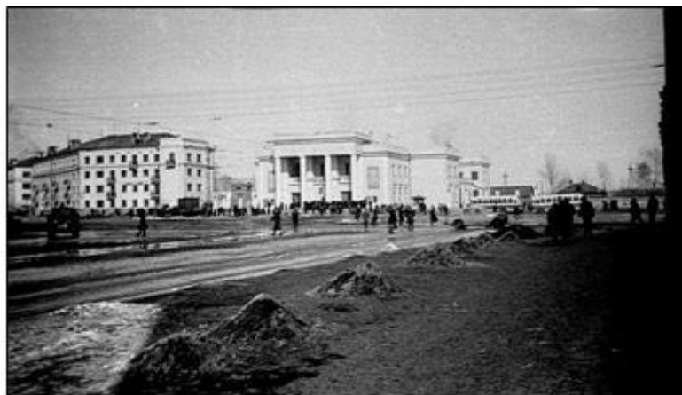
Клуб меланжевого комбината на Октябрьской площади. Рядом выстроен 4-х этажный дом по пр. Калинина, 4, но по Советской улице видны еще деревянные одноэтажные дома. Фото 1950-х годов.
