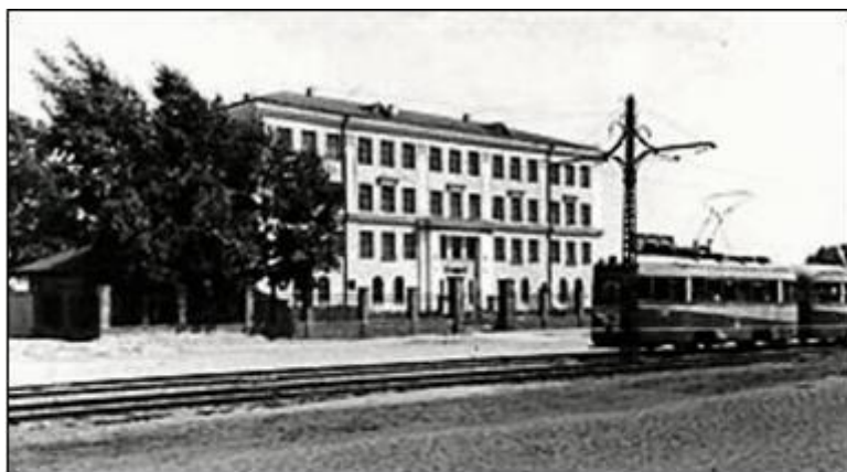
Здание средней школы № 42 на 960 учащихся, выстроенная в 1952 году. В настоящее время здесь лицей № 86. (пр. Красноармейский, 94). Фото 1954 г. ГААК. Фотоальбом № 36.
