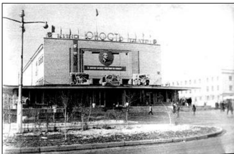
Кинотеатр «Юность», открытый в 1964 г. по ул. Тимуровская, 17. Здание построено по типовому проекту. Кинотеатр закрылся в 1990-х годах.
