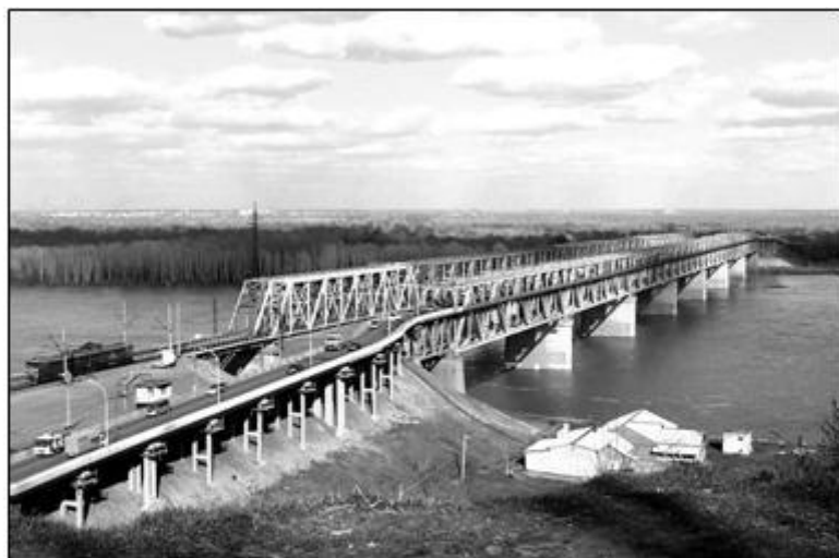
Барнаульские железнодорожные мосты через Обь. Справа - старый мост постройки 1915 г. с надстроенным автомобильным проездом в верхнем ярусе, слева - новый мост, построенный в 1987 г. Мост сооружен мостоотрядом № 96 Главмостстроя. Строительство продолжалось 7 лет.
