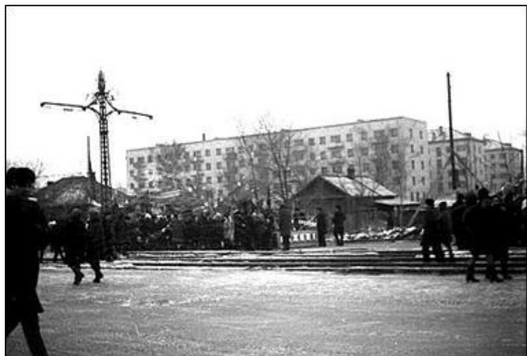
Красноармейский проспект на перекрестке с ул. Молодежной. Потоки воды после таяния снега. Фото 1970-х гг.
