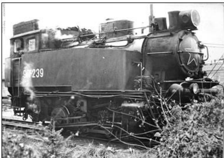
Паровоз 9П производит обкатку городских трамвайных путей перед сдачей их в эксплуатацию. Фото 1948 г.
