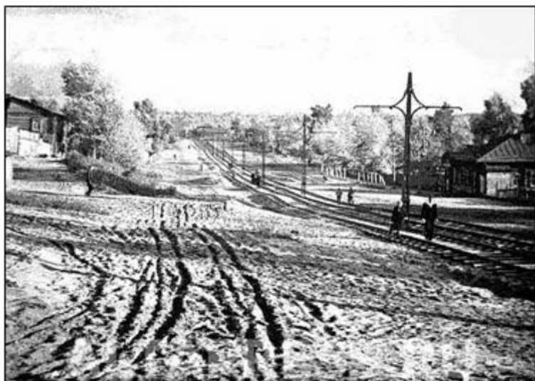
Строительство трамвайных путей по Красноармейскому проспекту. Фото 1947 г. Л.Борисенко.
