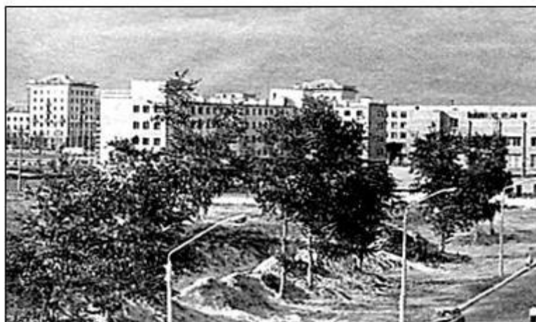
На этой площадке начинается строительство корпуса Алтайского государственного университета по ул. Димитрова, 66.
