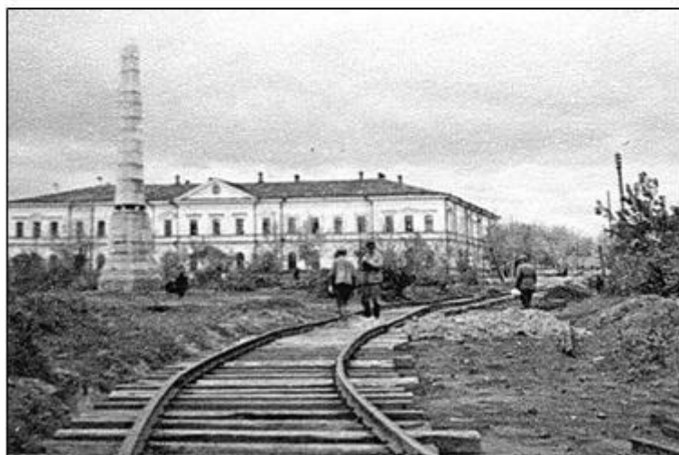
Прокладка рельсового полотна на повороте с Красноармейского проспекта на улицу Ползунова. Фото 15.09.1947 г. Л.Борисенко из фондов АГКМ.
