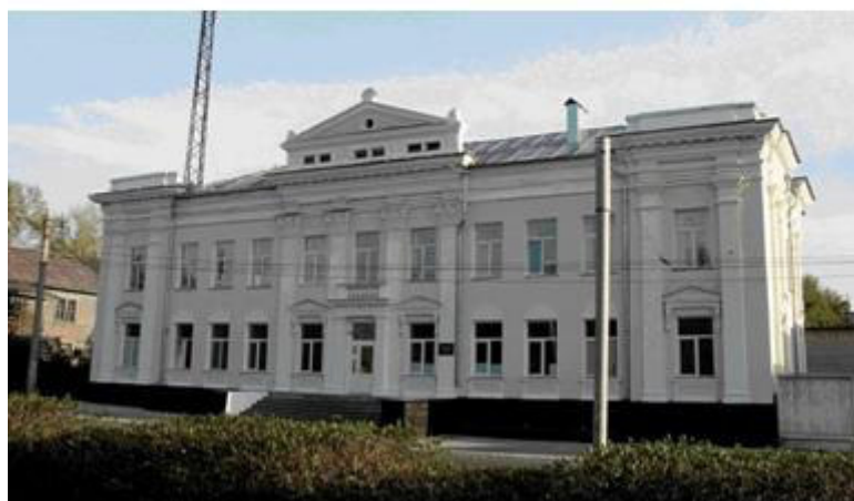
Административное здание Барнаульской дистанции связи Алтайского отделения железной дороги, построенное в 1953 г. (пл. Победы, 6).
