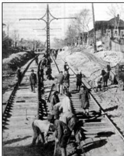
Строительство трамвайных путей по Красноармейскому проспекту. Фото 1947 г.
