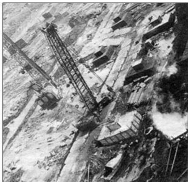
В середине 1980-х гг. на территории завода «Трансмаш» было начато строительство цветно-литейного завода. В 1990 году Москва прекратила финансирование этого объекта и строительство было закрыто. На снимке работы на строительстве завода.
