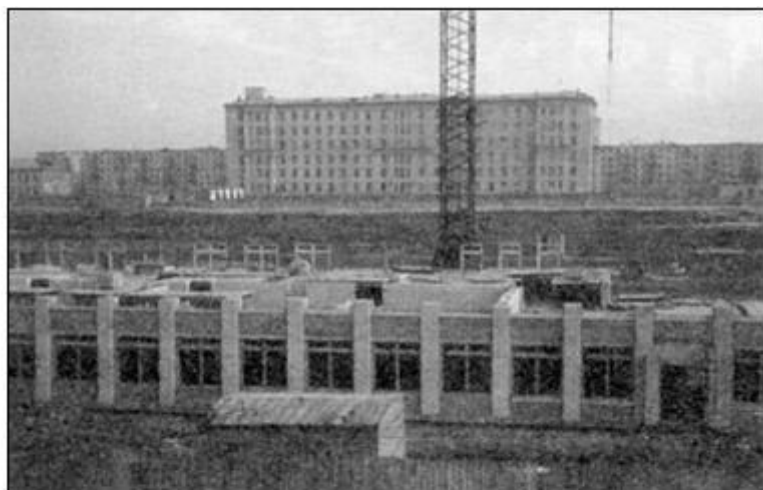
Строительство жилого массива на Потоке шло в комплексе со строительством социально-культурных объектов. На снимке строительство средней школы № 74 по ул. Эмили Алексеевой, 56 / ул. Глушкова, 21. Фото Люкшенко, середина 1960-х гг.
