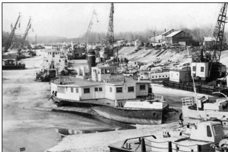
В 1978 г. завершил навигацию последний барнаульский колесный пароход «Прибой», списан в 1981 г. На снимке «Прибой» в Ковше. Фото 1981 г.
