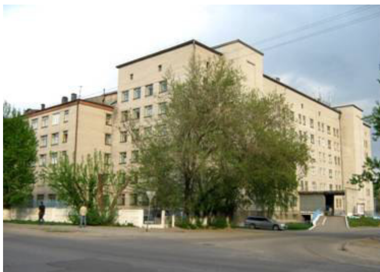
Городская больница № 8 (бывшая больница з-да «Трансмаш»). Построенная в 1987 г. (ул. П.Сухова, 13)
