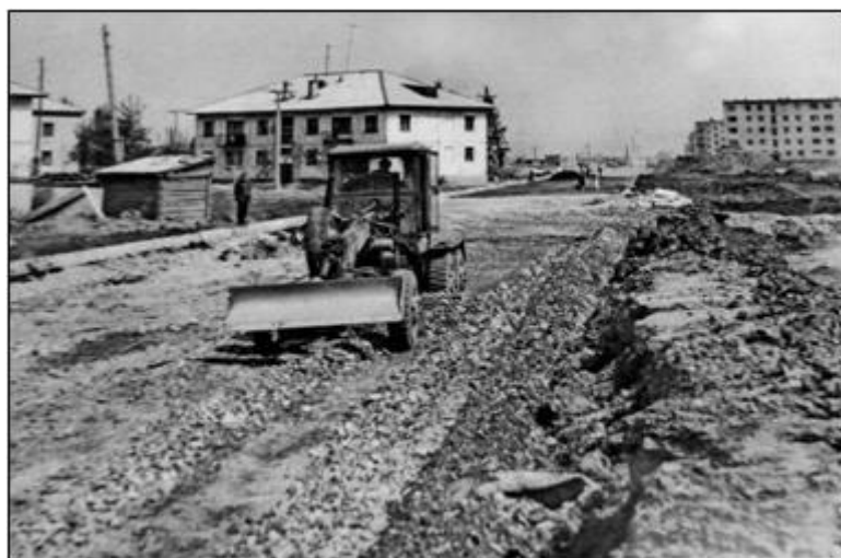
Строительство улицы Юрина в Ленинском районе. Фото 1973 г.
