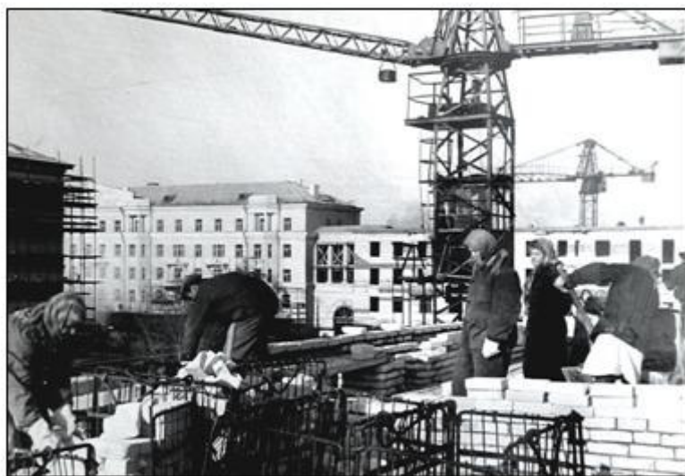
Идет строительство жилого дома № 2 станкостроительного завода по пр. Ленина, 73. Фото 1954 г. ГААК. Фотоальбом № 36.
