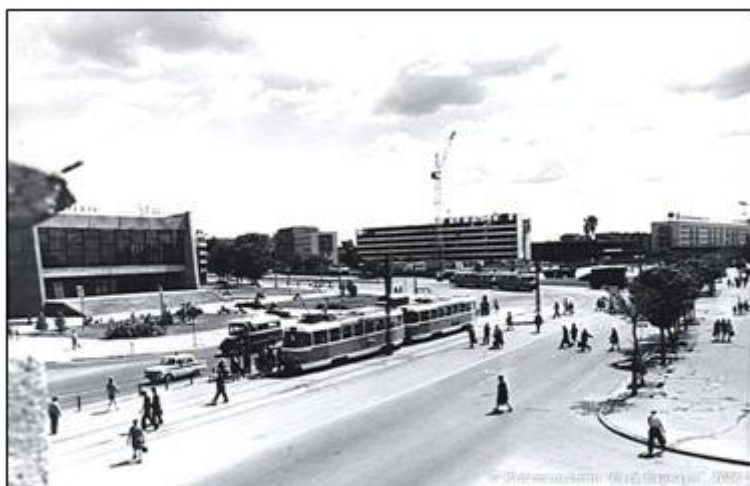
Проспект Строителей у площади Победы. На заднем плане - строительство гостиницы «Барнаул». Фото начала 1980-х г.г.
