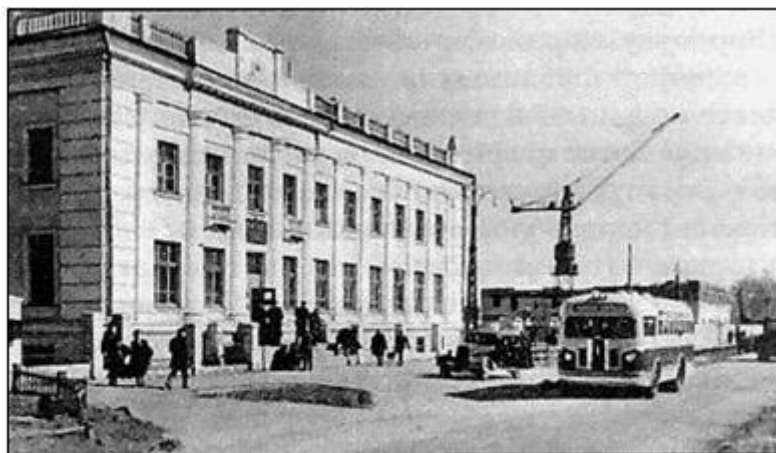
Административное здание, постройки 1951 г. Архитектор В.Л.Казаринов. Первоначально здесь размещался Промбанк. (пр. Ленина, 62). Фото 1950-х г.г. из фондов ГААК
