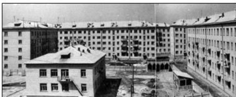
Жилой массив на Потоке из 5-и этажных домов. Фото 1967 г.
