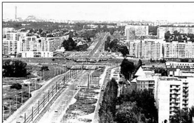
Дорожная развязка на перекрестке Павловского тракта и ул. Малахова. Построенные в 1970-х гг. два мостовых перехода через трамвайную линию обеспечивают ритм и безопасность движения транспорта
