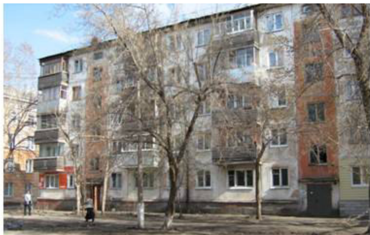
Первый панельный 5-и-этажный жилой дом в Барнауле был построен по ул. Союза Республик, 31. Фото автора, 2008 г.
