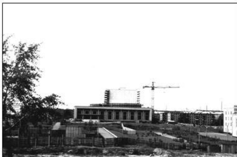
Завершается строительство здания краевого драматического театра. Фото 1972 г. А.С.Антошкина
