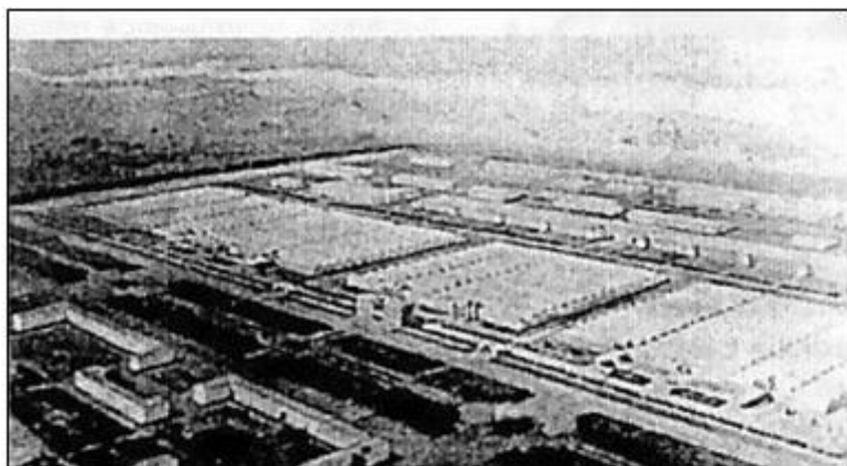
Панорама строительства Барнаульского хлопчатобумажного комбината. Фото 1952 г. из фондов ГААК.
