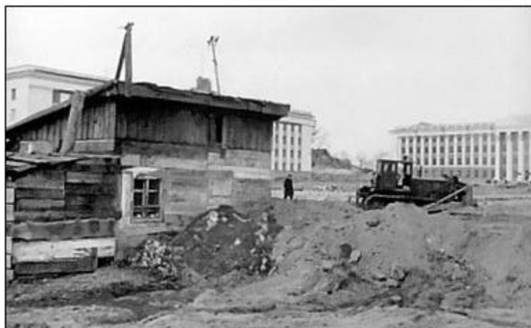
Строительные работы на площади Советов. Фото Н.Калинина, 1961 г., из фондов АГКМ.
