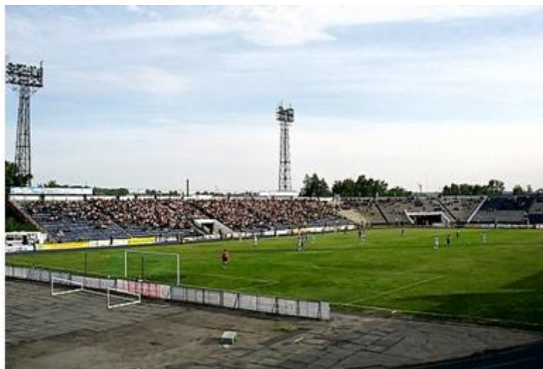
Центральный стадион Барнаула «Динамо». При реконструкции стадиона в 1960-х годах создано футбольное поле с дренажным покрытием, устроены трибуны для зрителей на 22 тысячи мест, установлено искусственное освещение.
