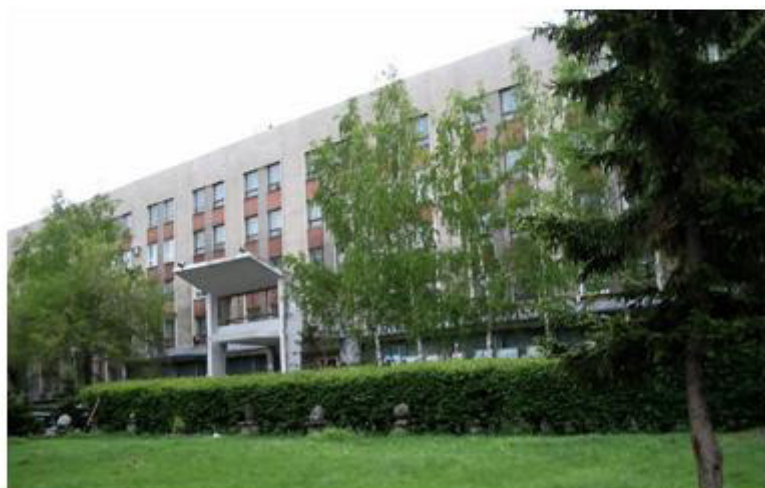
Здание Алтайского государственного университета. Построено в начале 1970-ых г. Архитектор Г.И.Первушина. (ул. Димитрова, 66). Фото автора, 2007 г.
