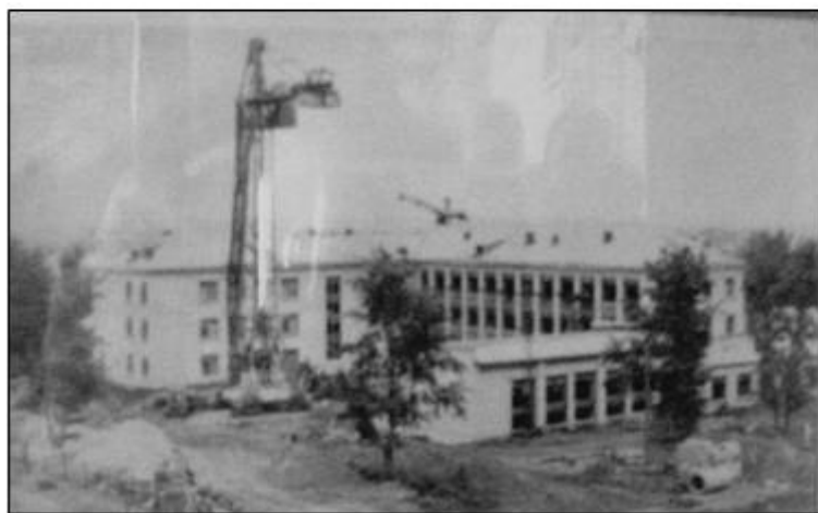
Строительство средней школы № 49. Фото Ю.Литвинова, 1968 г. (ул. Горно-Алтайская, 7).
