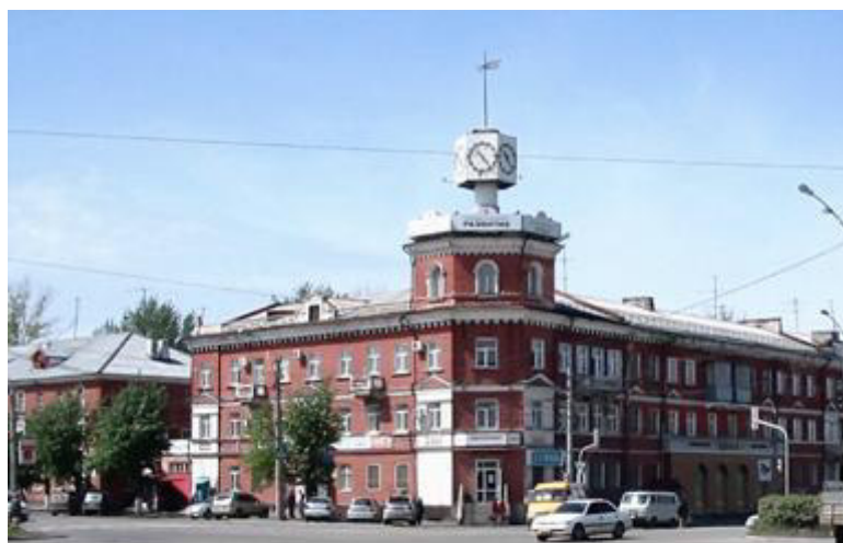
Жилой дом с административными помещениями. Построен в 1976 году. Архитектор Г.И.Первушина. (пр. Строителей, 22)
