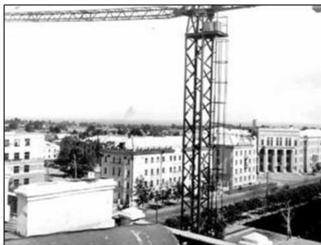
Строительство жилых домов на Ленинском проспекте в районе кинотеатра «Россия». 60-е годы XX века.
