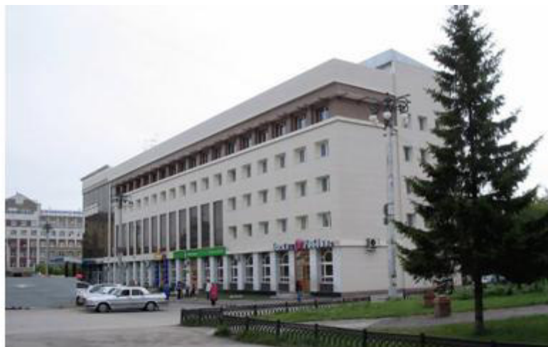
Здание гостиницы «Центральная» после реконструкции. (пр. Ленина, 57). Фото автора, 2007 г.
