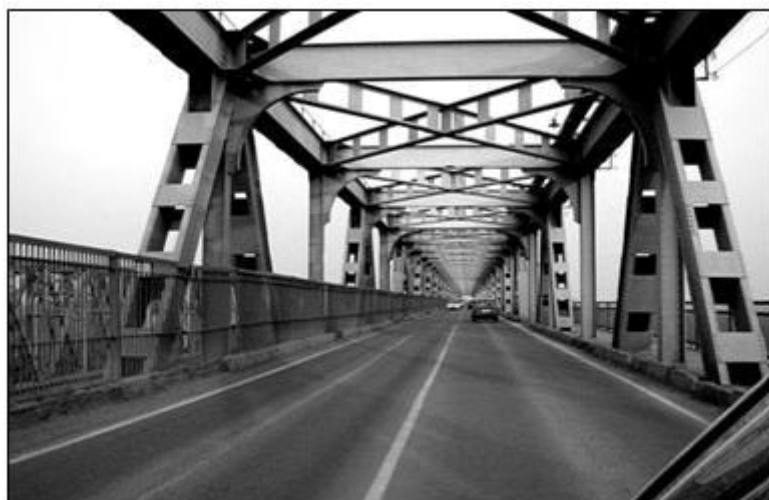
Устройство в 1959 году автомобильного перехода по железнодорожному мосту разрешило транспортную проблему переправы через Обь. Строительство вел мостоотряд № 403.
