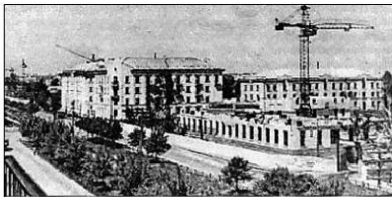
Начало строительства здания Строительного техникума по пр. Ленина, 68. Строится первый этаж. 1947 г. из фондов АГКМ..
