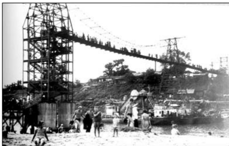
На верхнем снимке левая береговая опорная мачта подвесного моста, на нижнем - правая береговая мачта. Фото начала 1960-х гг
