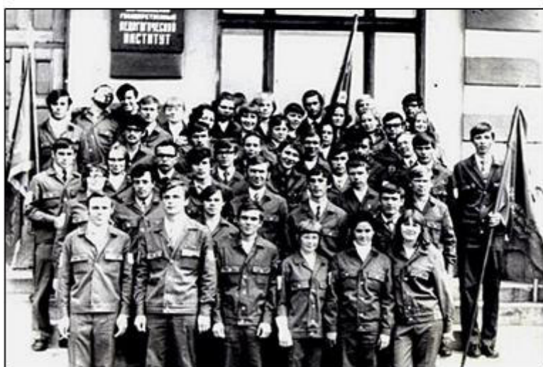
Со временем студенческие строительные отряды приобретали опыт работы и форму. На снимке строительный отряд «Квант-73» Барнаульского государственного педагогического института. Фото 1973 г. из архива АГПА.
