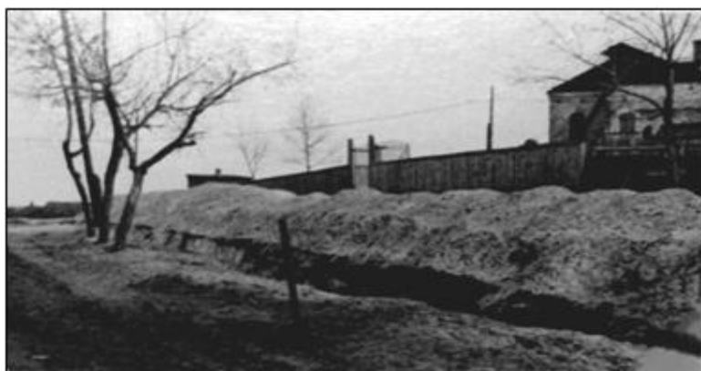
Прокладка водопровода в городе. Фото Л.И.Борисенко из фондов АГКМ. 1953г.
