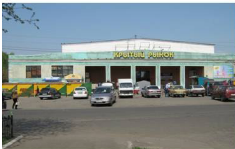
В 1974 году на Потоке вступил в строй первый в Барнауле крытый рынок. Фото автора, 2008 г.
