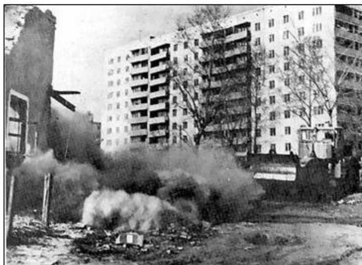
Сносится последний из 131 бараков, доставшихся заводу «Трансмаш» от военных лет. На снимке видно построенный на месте бараков новый 10-и этажный жилой дом. Фото 1980 г.
