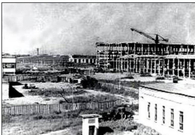
Строительство главного корпуса Барнаульского шинного завода. Фото 1968 г.
