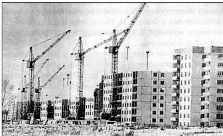
В 1970-е годы широкое развитие получила застройка окраин города микрорайонами. Строились крупнопанельные дома с применением блок-секций. ГААК. Фотоальбом № 216.
