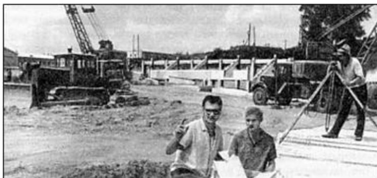
Начало строительных работ по сооружению Дворца спорта и зрелищ. Фото 1960-х гг. из фондов ГААК. Фотопозитив № 220
