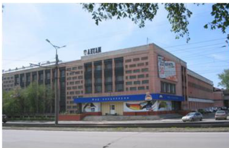
Издательско-полиграфическое предприятие «Алтай». Здание построено в 1969 г. (пр. Красноармейский, 25). Фото автора. 2007 г.
