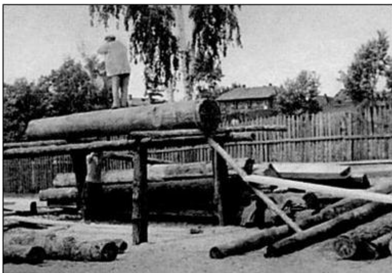
Для строительства и ремонта частных домов в послевоенные годы была острая нужда в пиломатериалах. На снимке - ручная распиловка бревен на доски. Фото 1948 г. Л.И.Борисенко из фондов АГКМ.
