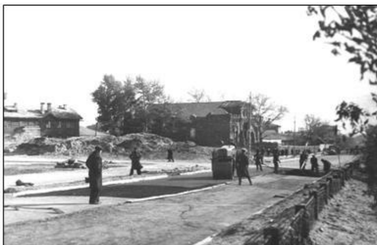
Работы по асфальтированию проспекта Ленина. В центре снимка видно здание бывшей Никольской церкви. Фото Л.И.Борисенко из фондов АГКМ. 1954 г.
