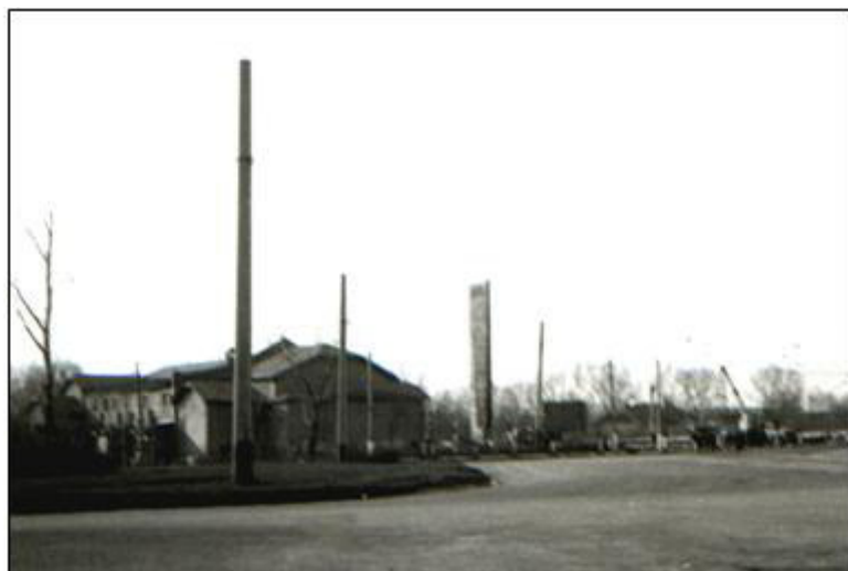
Монтаж стелы на строящемся Мемориале воинской славы. Слева видно здание железнодорожного клуба. Фото 1971 г. А.С.Антошкина.
