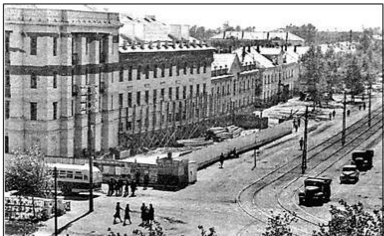
Проспект Ленина на пересечении с улицей Новой (ныне пр. Строителей). Завершается строительство углового дома. Фото 1953 г. Н.Н.Калинина из фондов АГКМ.
