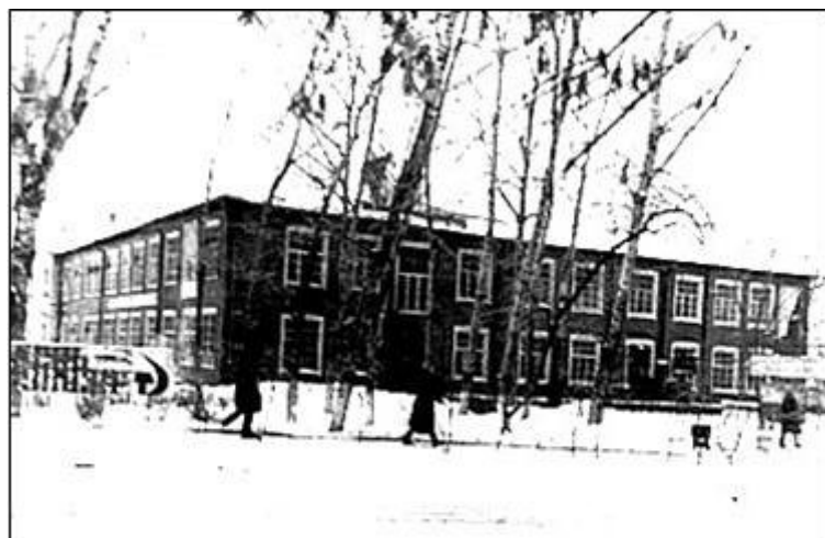
Здание, в котором размещалось Барнаульское отделение железной дороги. Фото 1945 г.
