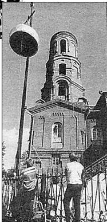
Установка купола на заново отстроенную колокольню Покровского собора. Фото 1990 г. А.Каспришина.
