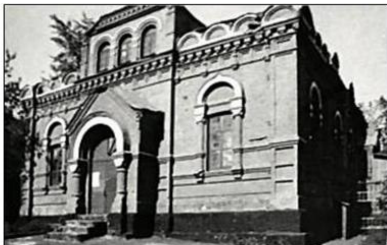
Церковь Святого Николая Чудотворца, по пр. Ленина. В 1924 г. церковь была закрыта и передана под красноармейский клуб. Купола и верх колокольни были снесены.
