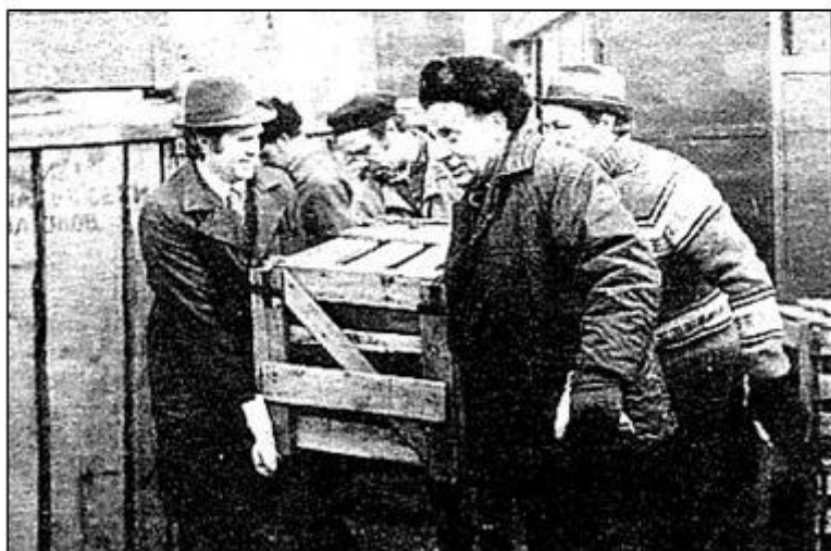
Для обеспечения дальнейшего развития машиностроения, в 1974 г. в Барнауле был создан проектный институт «Сибгипросельхозмаш», ставший затем главным проектным институтом отрасли. На снимке субботник на строительстве корпуса института. Фото 1980-х гг.
