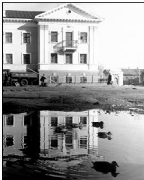
Красноармейский проспект возле дома № 46. После дождя здесь благодать для водоплавающей птицы. Фото Л.И.Борисенко из фондов АГКМ. 1949 г.
