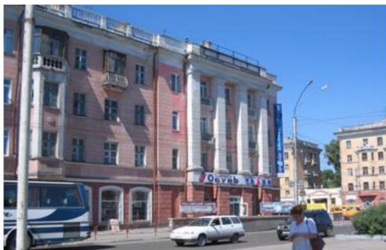
Жилой дом с административными помещениями, который в 1954 году для своих работников выстроил котельный завод. В настоящее время на первом этаже книжный магазин «Вас-Книгас», обувной магазин и др. (пр. Ленина, 85 / пр. Строителей, 1). Фото автора, 2006 г.
